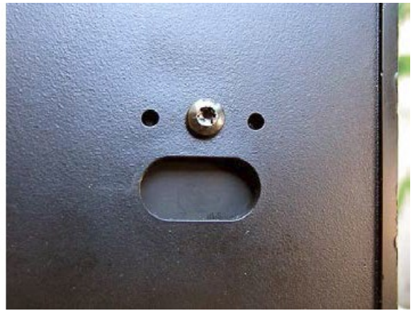
Der stillgelegte Netzanschluss.
